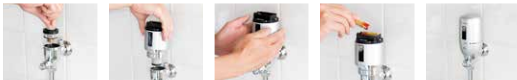
① 取り外す ② 差し込む ③ ねじ込む ④ 電池を装着 ⑤ 完成
